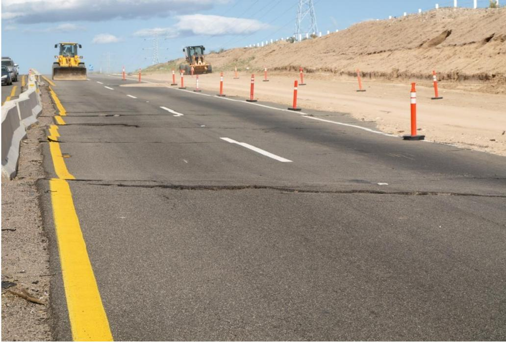
A los lados de la carretera y sobre la margen oriental del Cerro del Centinela (Fotografía), se observa el trazo de la falla Pescaderos (?) que se activó con el temblor,
