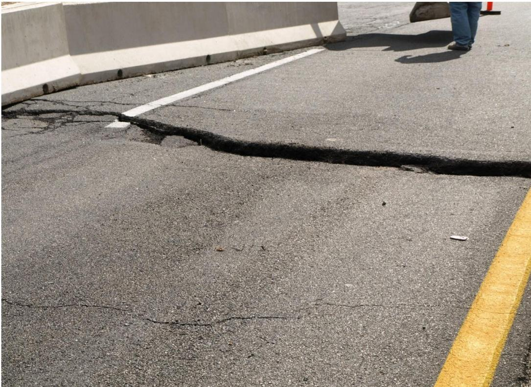
Aquí mismo se pudo observar la naturaleza del movimiento de la falla que generó el sismo. En la siguiente fotografía se puede ver a lo largo del trazo de la línea amarilla el sentido de movimiento horizontal, característico de una falla de rumbo lateral derecha
